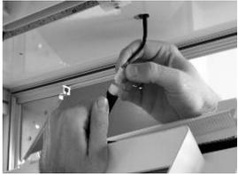
Verbinden Sie das mitgelieferte Anschlusskabel mit der im Fahrzeug verlegten Stromversorgung.
